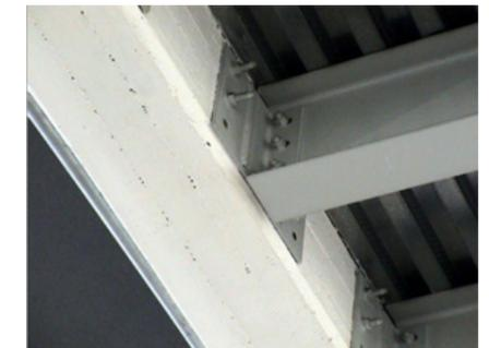
Attache d'une poutre en acier
